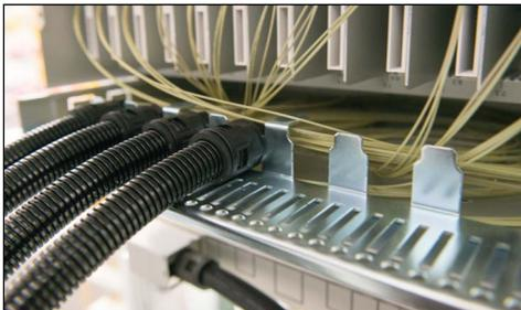
Rohrverschraubung auf BGT montieren und Flex Rohr einführen
