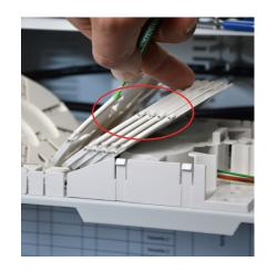
10. Bei weiterer Rohr- und Kabelbestückung gemäß der Rohrbelegung (Aufkleber) vorgehen und die Schritte 1. bis 9. wiederholen.
