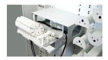
3. ankommendes Stammkabel abmanteln und auf Kabelabfangplatte mittels Kabelschellen befestigen. Das Zentralelement ggf. mittels Abfangklemme befestigen.
