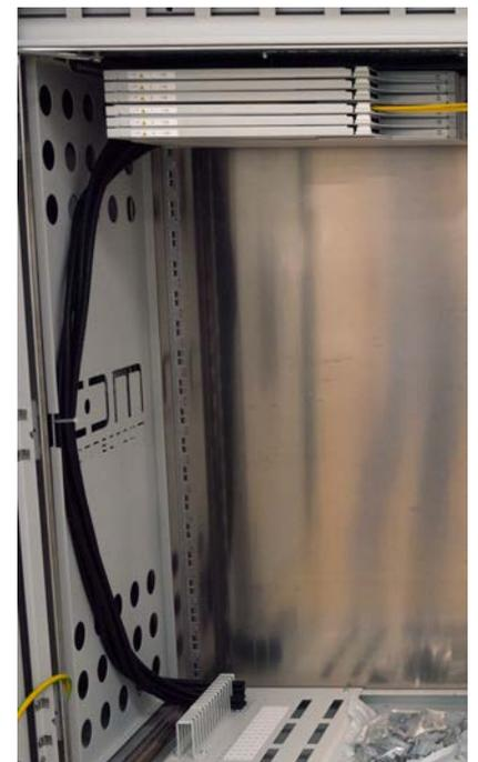
Die Flexschläuche werden, wie im obigen Schema dargestellt, in den Rohrkamm eingelegt. Begonnen wird mit dem Schlauch der ersten Schublade des obersten Panels. Von dieser Position aus wird der Rohrkamm von der MFG Rückwand Richtung der Vorderseite belegt.
