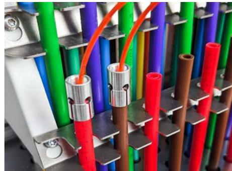
**6C**Mikrorohr **zwingend** nach Einführen und/oder Einblasen des Kabels mit Gas-Wasser-Block **abdichten**, um das Eindringen von Feuchtigkeit zu verhindern.
