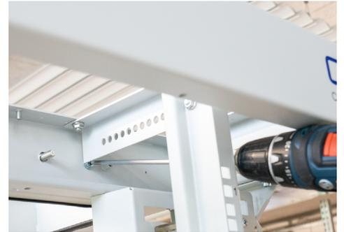
Verschraubung der CARMA Racks an den 8 definierten Punkten
